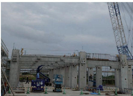
仮設計画に基づき重機を配置
