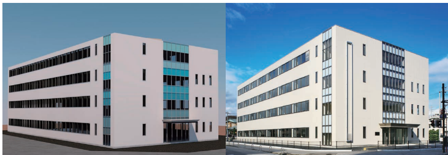
栃木県発注の建物の色決めなどに使った BIM モデル(左)と実物の建物(右)
