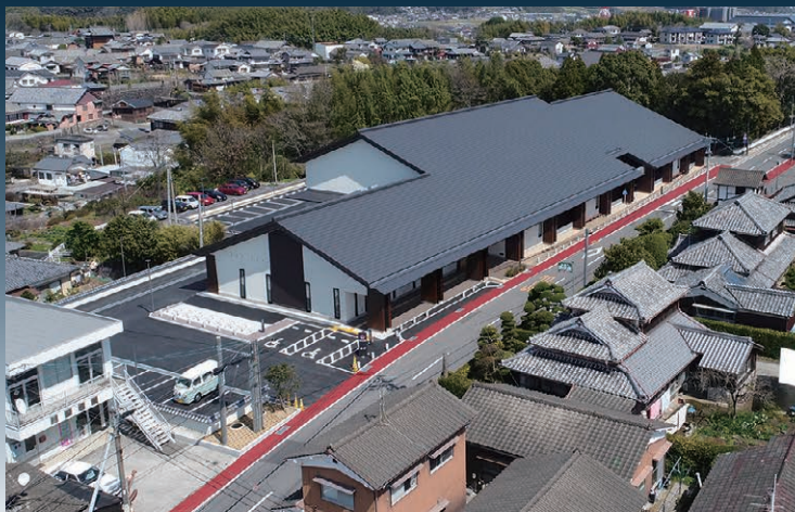
■旧城下町の風情によく馴染む杵築市立図書館全景
