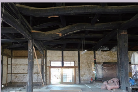
「立正寺」解体写真
