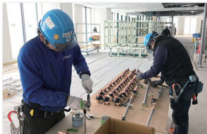
現場での施工状況(プレファブユニット化)
