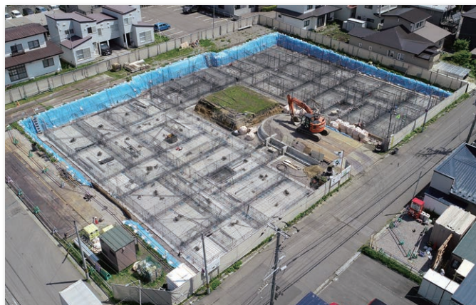
「函館プロジェクト」現場風景（基礎工事）
