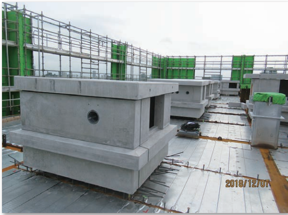
施工現場の状況(2018年12月)
